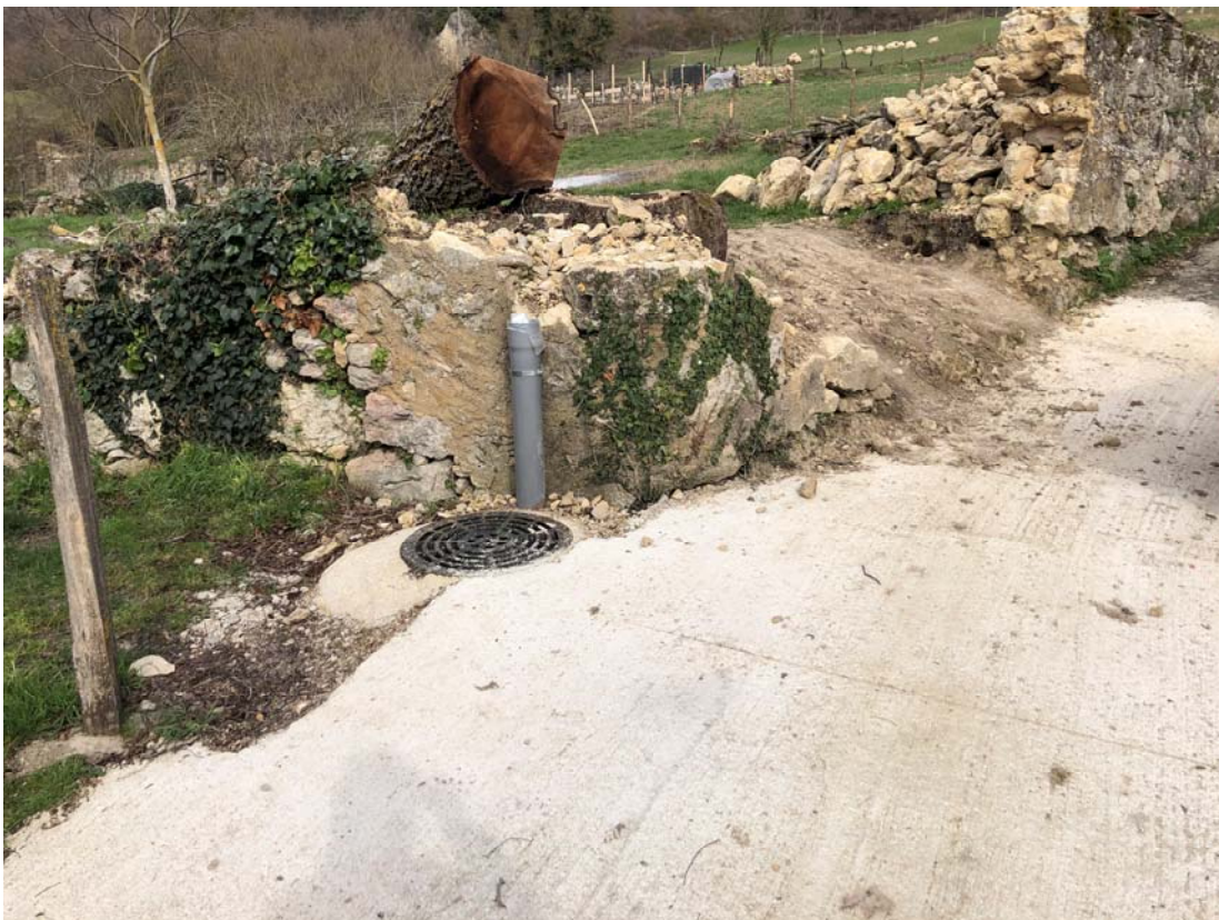
Acometida de aguas pluviales de la parcela 324 del polígono 1. De reciente creación.
