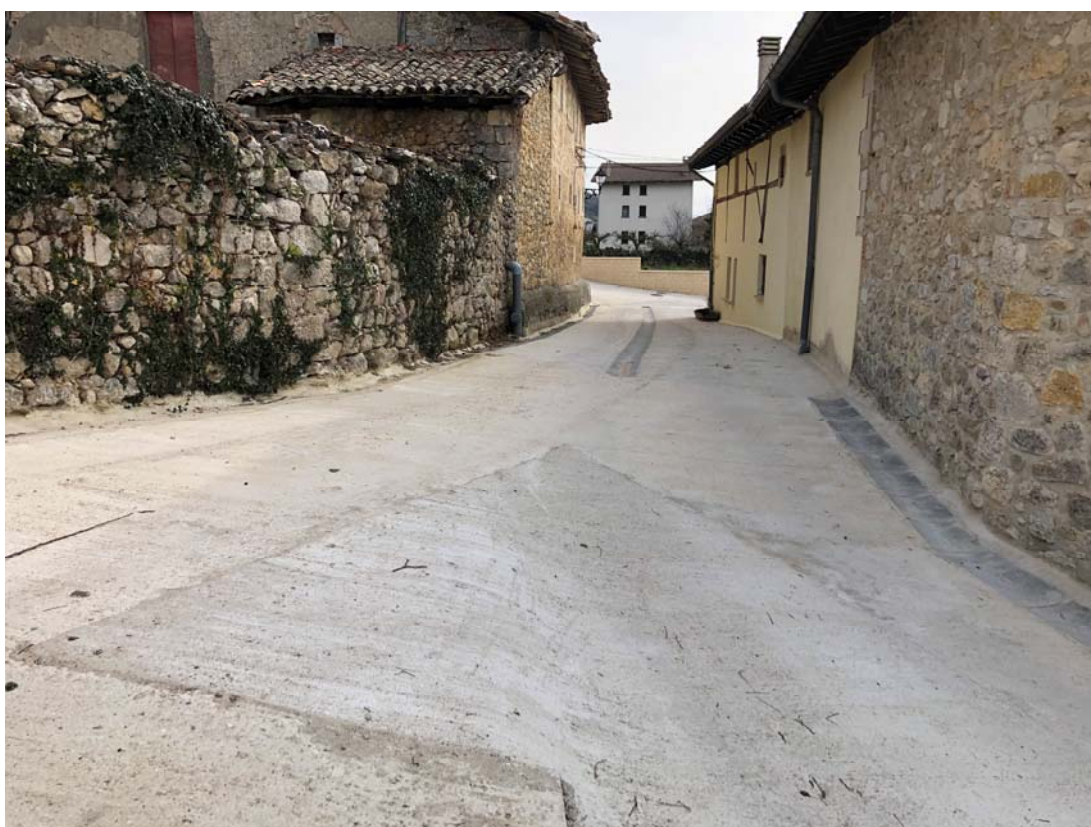
Calle Gonea, recientemente urbanizada con recogida de aguas pluviales y resto de servicios
