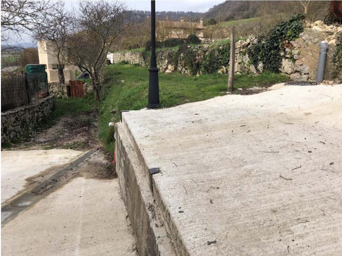
Nueva pavimentación de calle Gonea, esquina sureste de la parcela catastral 324 del polígono 1
