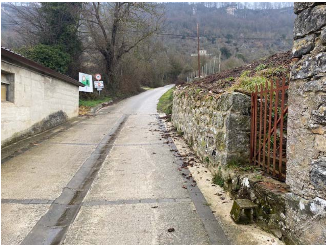
Calle de acceso peatonal y vehicular a regularizar en su parte oriental (talud natural).
