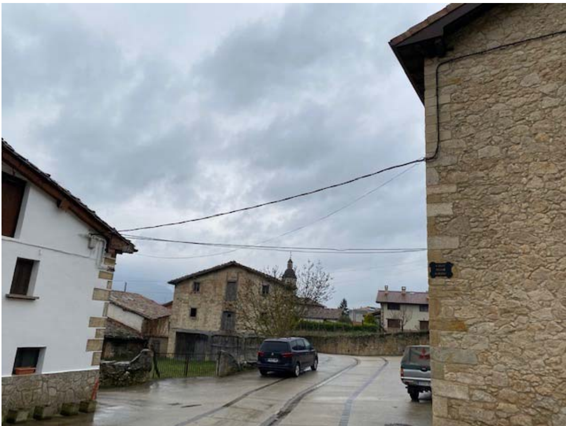
Acometidas de servicios en calle Copalacio Alto, ubicadas a 25 metros de la parcela catastral 357 del polígono 1
