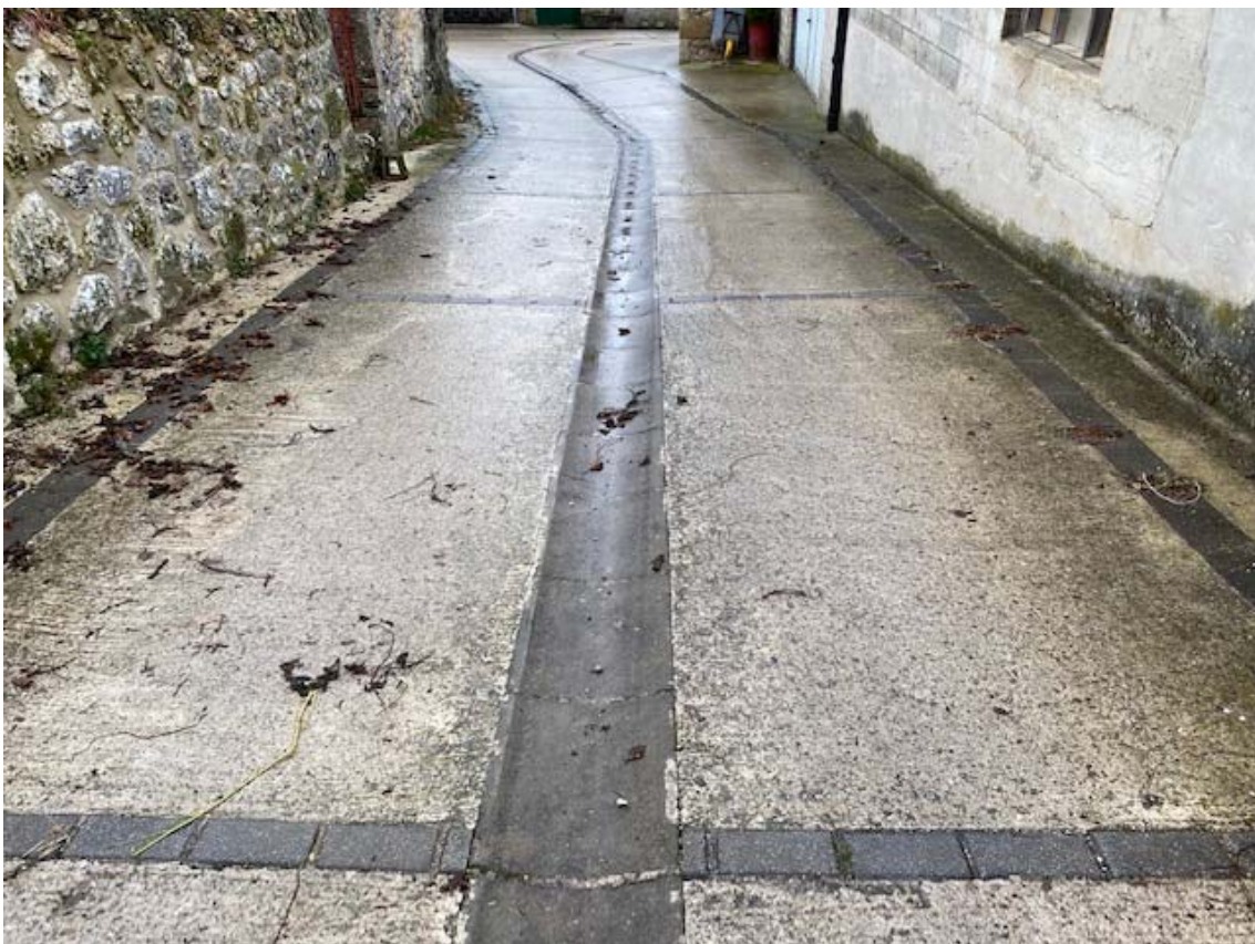
Nueva pavimentación del inicio del camino, de acceso a la parcela catastral 357 del polígono 1
