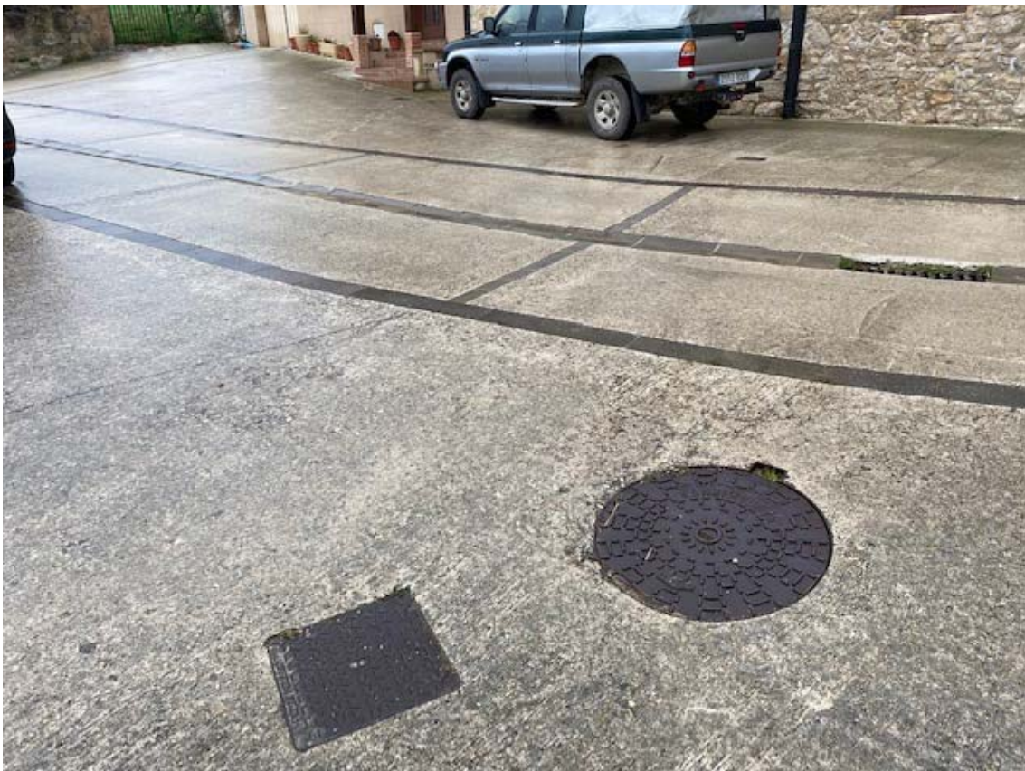
Acometidas de servicios de vivienda colindante en calle Copalacio Alto
