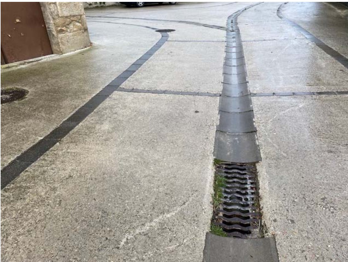
Colectores generales de servicios en calle Copalacio Alto, recientemente urbanizada, al sur de los terrenos
