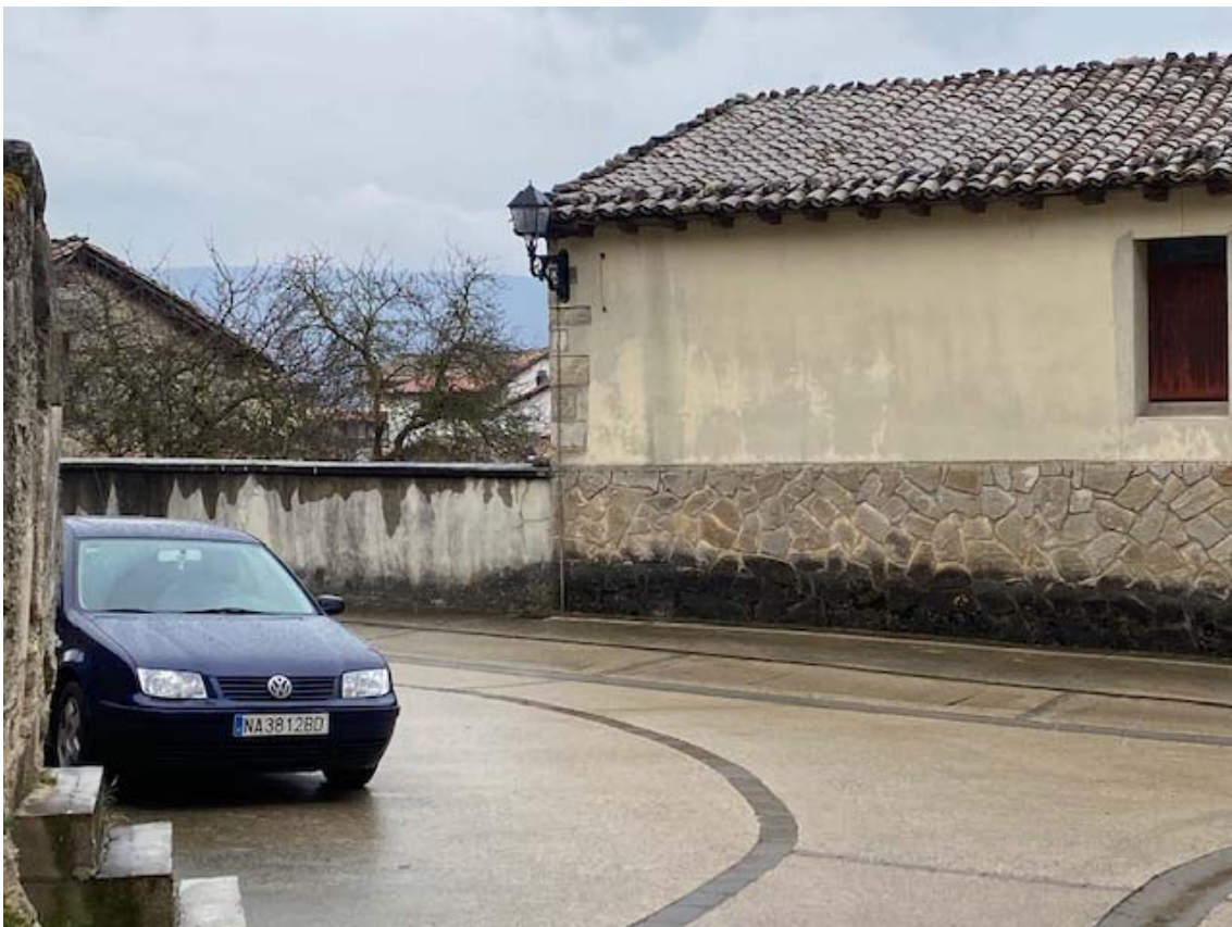
Calle Copalacio Alto, urbanizada con recogida de aguas pluviales y resto de servicios
